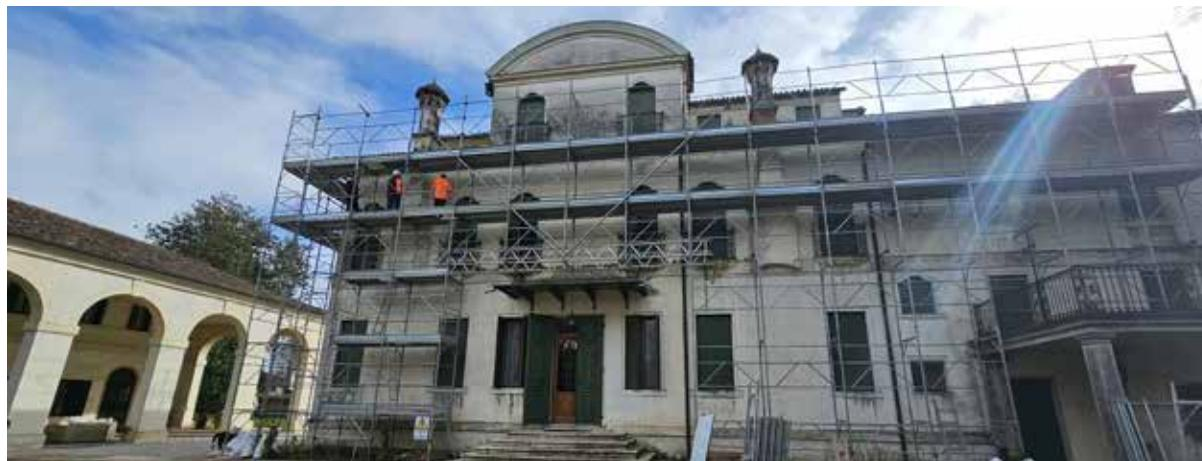
consistiti in una completa rimozione del piano di copertura in coppi (a canale e di coperta), la loro pulizia e l’eliminazione degli elementi non più riutilizzabili cui è seguita
